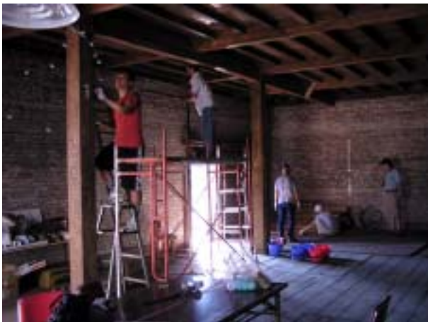
天井の埃を取り掃除する様子（9月21日）
