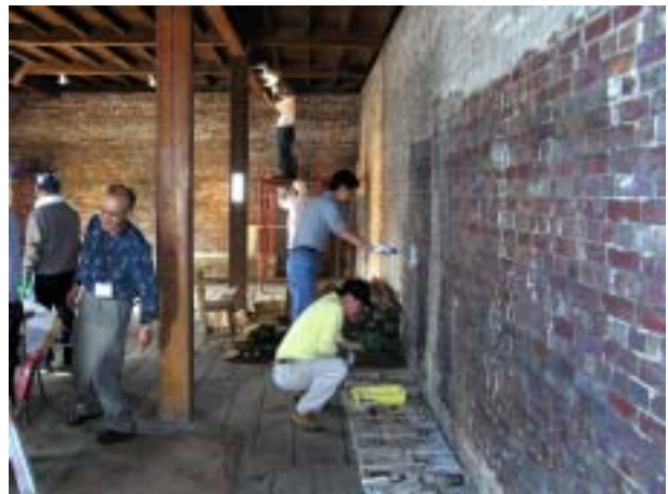
「シーラー」を塗る様子
