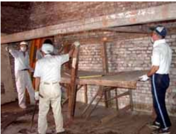
棚を木槌でたたいて分解してから撤去する様子
